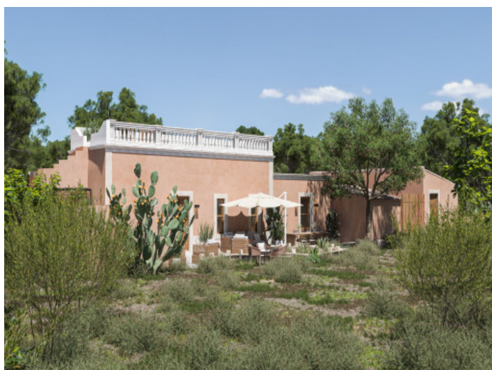
Finca de nueva construcción en Formentera
