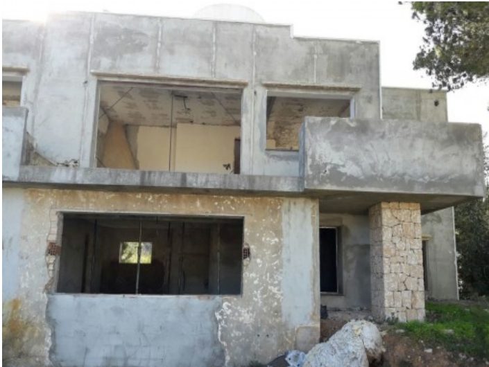
Vista exterior de la finca
